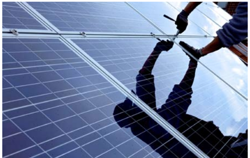
Montage einer Photovoltaik-Anlage
