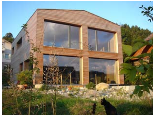
Minergie-Haus an der Napfstrasse in Langnau
