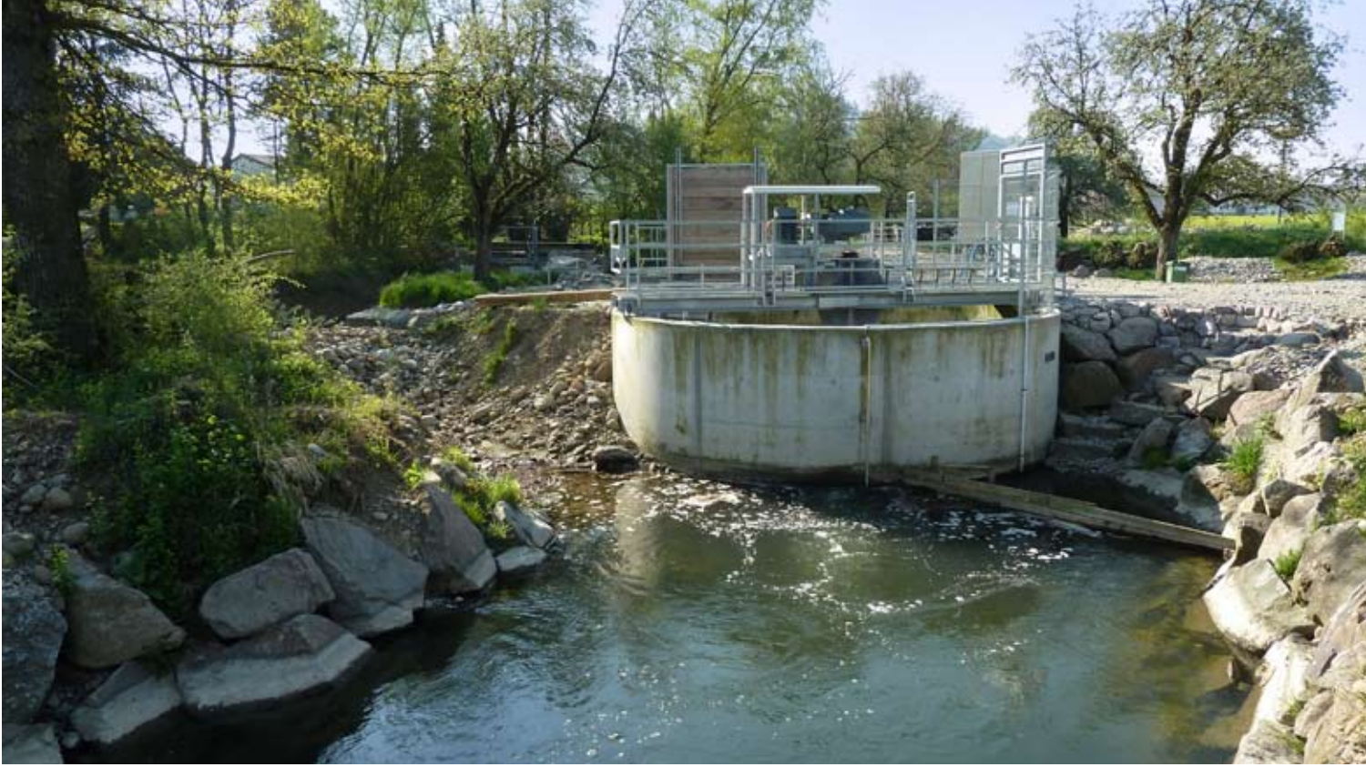
Das Wasserwirbelkraftwerk in Schöffland
