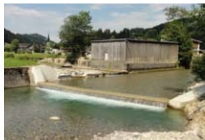
Die Iffis in Trubschachen: geeignet für die Nutzung der Wasserwirbelkraft
