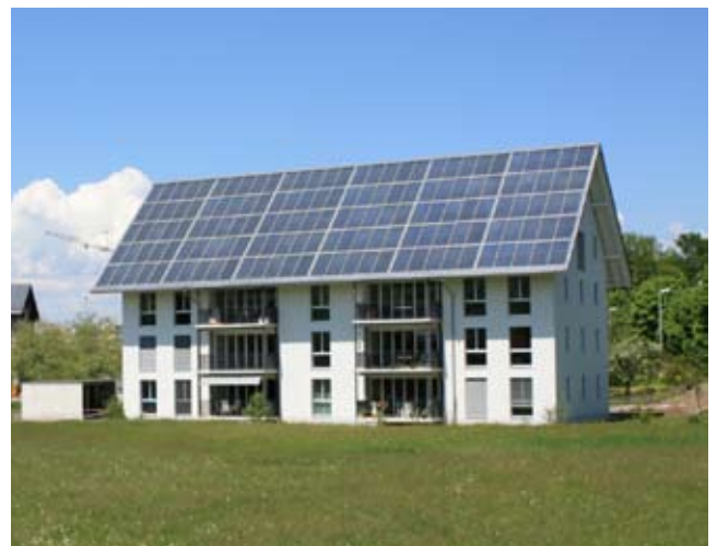
Erstes vollständig solar beheiztes MFH Europas in Oberburg!
