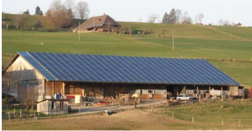
Das Süddach des Löhlihofs ist auf 810 Quadratmetern mit Solarmodulen zur Stromgewinnung überdeckt, ganz links eine Reihe Warmwasserkollektoren.
